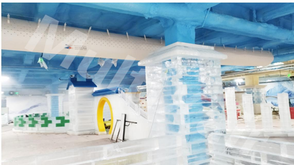
4、清洗方便：因为纤维织物是纤维布为主要风管，所以清洁时只要取下布风管，送工业清洗，清洗完毕再安装上也是非常方便的，这些相较于传统的金属风管比，势是非常突出的。5、设计更随心，安装更方便：而在纤维织物的设计方面，其在布置场馆内部时，因为纤维织物的柔软度，所以其设计可以高度符合客户想要的，安装也比传统金属风管简单很多。纤维织物风管、布袋风管、空气分布器等，是由特殊纤维织成的空气柔性分布系统，主要靠纤维渗透和喷孔射流的独特出风模式，能均匀送风的送出风末端系统。传统金属风管很难清洁，或者清洁费用太高。米希（上海）环境技术有限公司是一家专业提供软风管的公司，欢迎您的来电！扬州阻燃软风管尺寸
